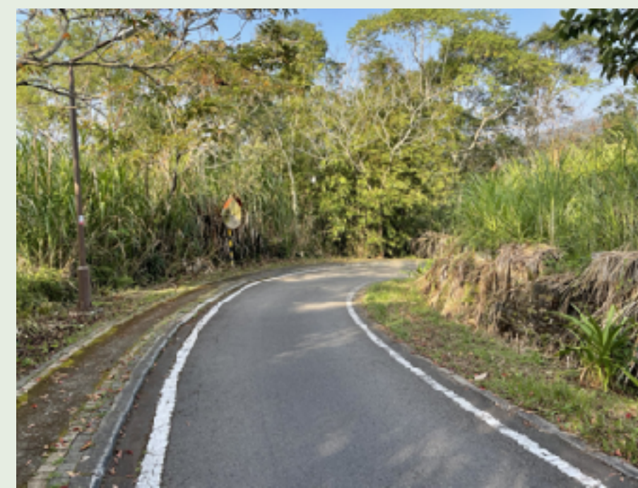
近停機坪危險彎道
